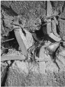
图 7 边墙破坏图
