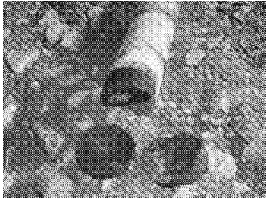
图 9 钻孔取芯确定缓冲层压缩后的厚度
