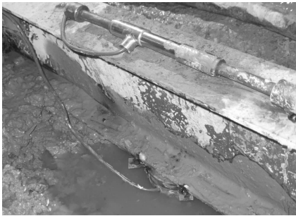
图 6 压力盒及钢筋计埋设图
