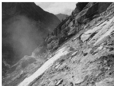
图 1 双江口水电站 27#危岩体
