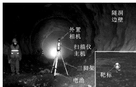
图 2 三维激光扫描仪在隧洞中工作
