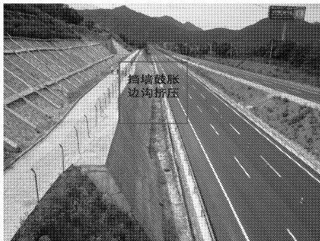
图5 挡墙鼓胀及边沟挤压
