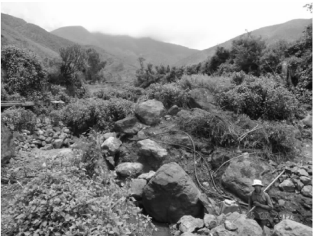
图 3 盖板涵不远处较大块石
