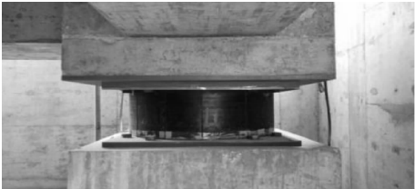
图 3 支座现场节点照片
