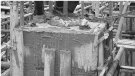
图 6 柱头刮除浮浆、加干碎石振捣
