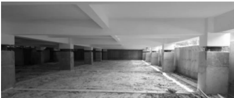
图 2 基础隔震结构
