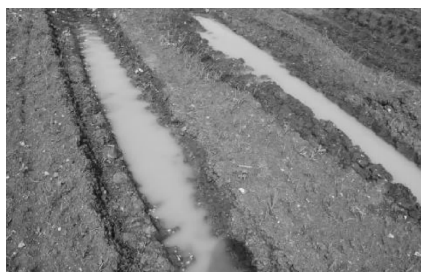
图 1 852 灌区道路雨后水坑浑浊
