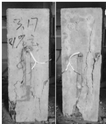
图 2 表面被裂缝贯穿的试件
