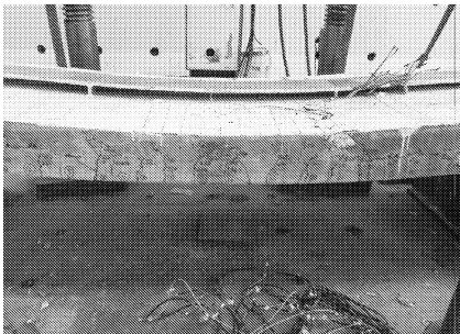
(c) 试件破坏后板侧边裂缝分布
