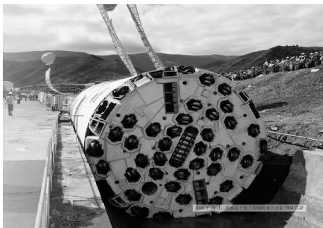
图1 TBM掘进设备启动
