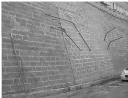
图 6 挡墙裂缝
