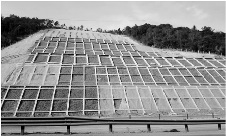
图 2 边坡支挡工程
