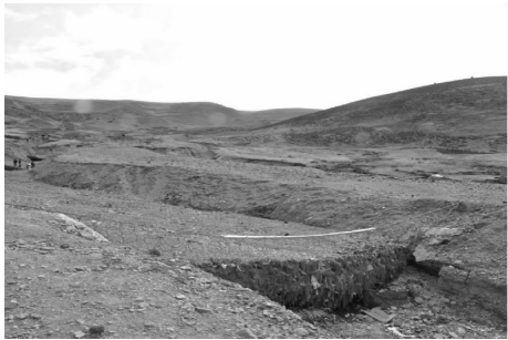
图 2 泥石流被拦截形成一个新的防护屏障
