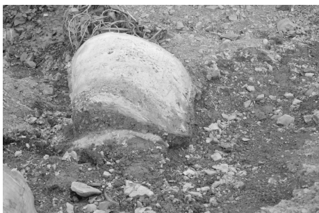
图 8 基础破坏
