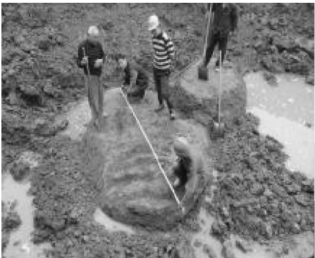
图 4 高压旋喷注浆试桩开挖检验
