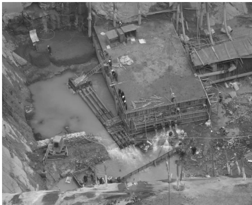
图4 银盘水电站岩溶渗漏处理实景图
