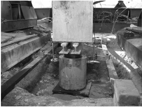
图 1 现场载荷试验图
