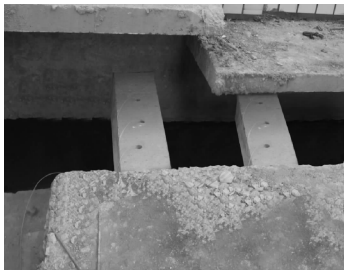
图 15 推移顶杆爆破导线布置
