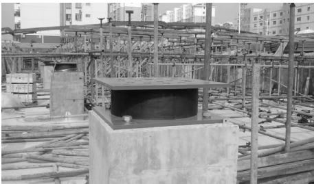
图 5 隔震橡胶支座施工安装
