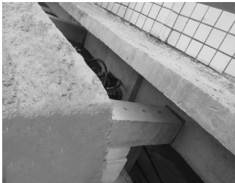
图 14 推移顶杆安装图
