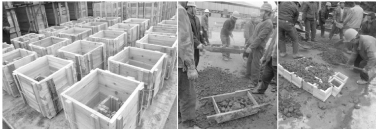
图 1 混凝土试件浇注现场
